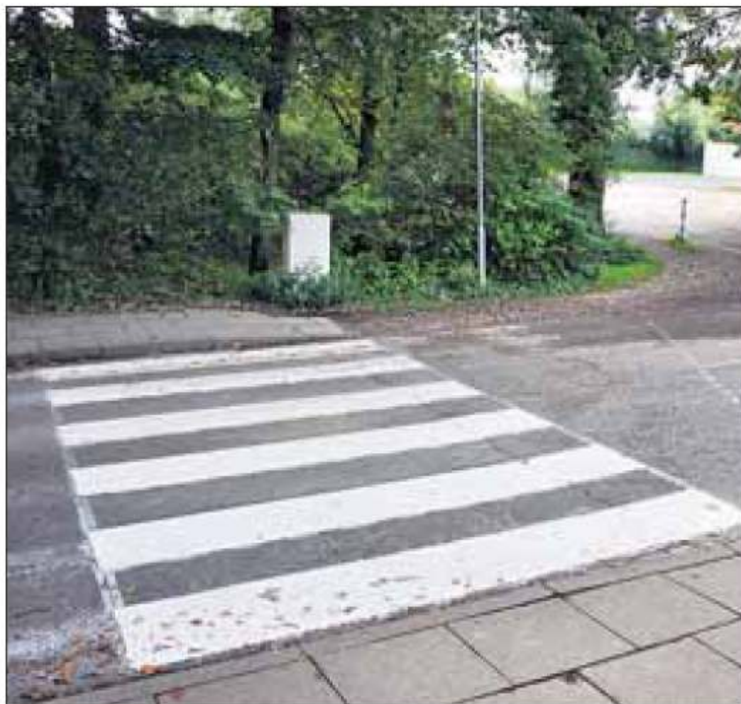
Deutlich ist der schräge Zebrastrreifen noch auf dem Wendelweg zu sehen.
